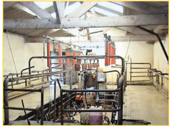
Salle de traite lumineuse avec translucides
