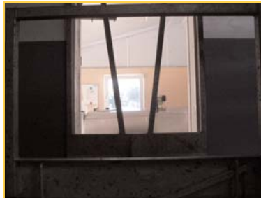
Pont-levis avec éblouissement
